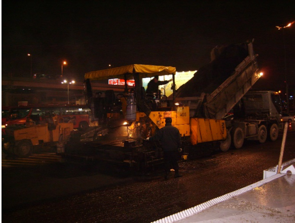
[2007, 서울시 도로 보수공사]
